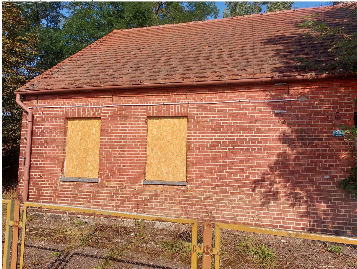
Zdjęcie 1 Budynek dawnej szkoły w Górecku.
